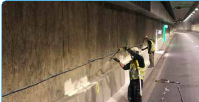
AANBRENGEN AQUAPROOF CEMFLEX OP BETONPLINTEN LEOPOLD 2 TUNNEL
