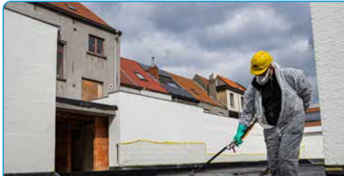
APPLICATIE HORIZONTALE DICHTING MET MET AQUAPROOF 2K
