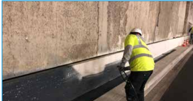
AANBRENGEN ISOPROOF FR ALS EINDLAAG OP BETONPLINTEN LEOPOLD 2 TUNNEL
