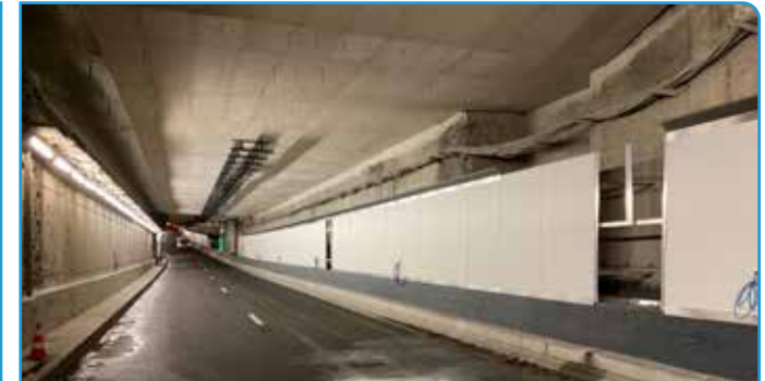
BETONPLINTEN NA PLAATSING VAN DE AFWERKINGSPANELEN
