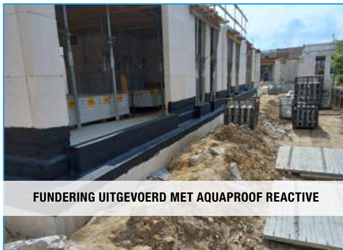
FUNDERING UITGEVOERD MET AQUAPROOF REACTIVE
