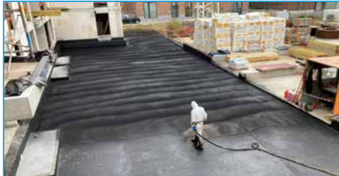
KELDERDAK EN STORTNAAD BEHANDELD MET AQUAPROOF 2K
