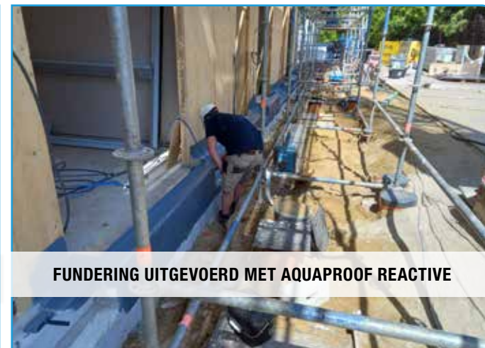
FUNDERING UITGEVOERD MET AQUAPROOF REACTIVE
